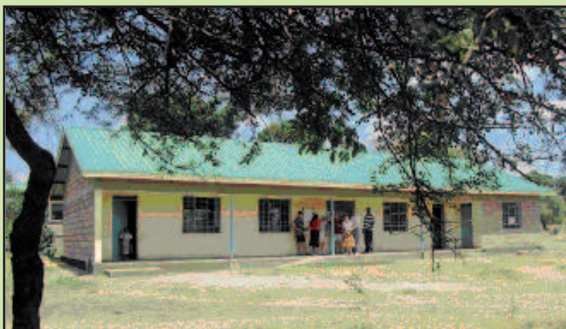
La scuola materna realizzata e funzionante da gennaio 2011
